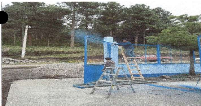
Foto 5: Mantenimiento y pintura de puertas y portones.
